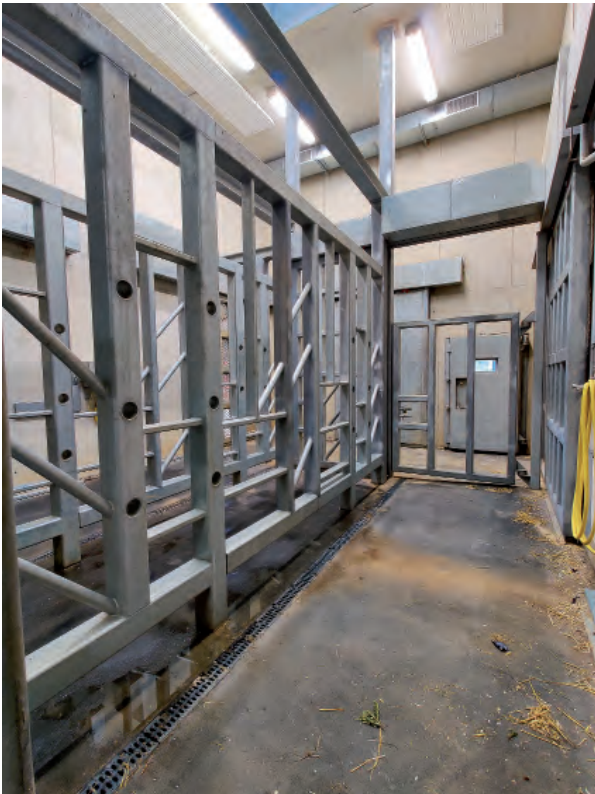
Abb. 11: Der Trainingsstand oder Chute wird von den Elefanten regelmäßig passiert. Das tägliche Training findet aber in den Ställen statt. Dies ist der einzige Bereich, der statt eines Asphaltbodens mit einem Gummiboden ausgelegt ist. Foto: Zoo Dresden
