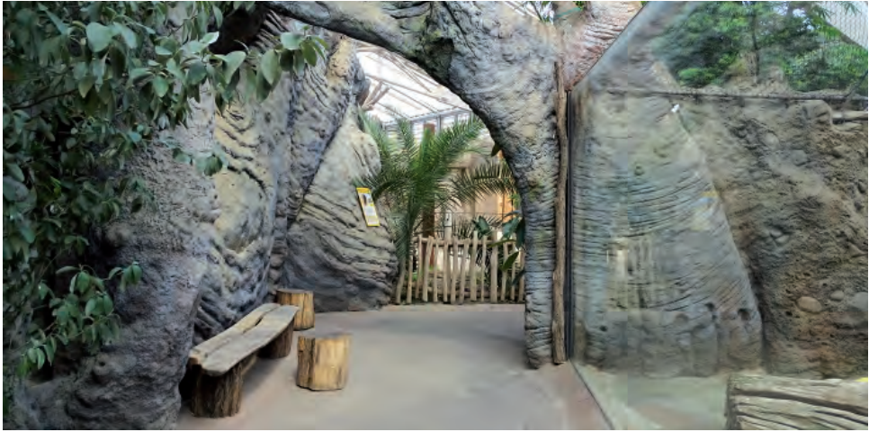
Abb. 21: Der barrierefreie Besucherweg durchs Afrikahaus wurde aus Prägebeton gefertigt. Große Panoramaischeiben ermöglichen Besuchern den Einblick in die Anlage der Mandrills (rechts). Foto: Zoo Dresden
