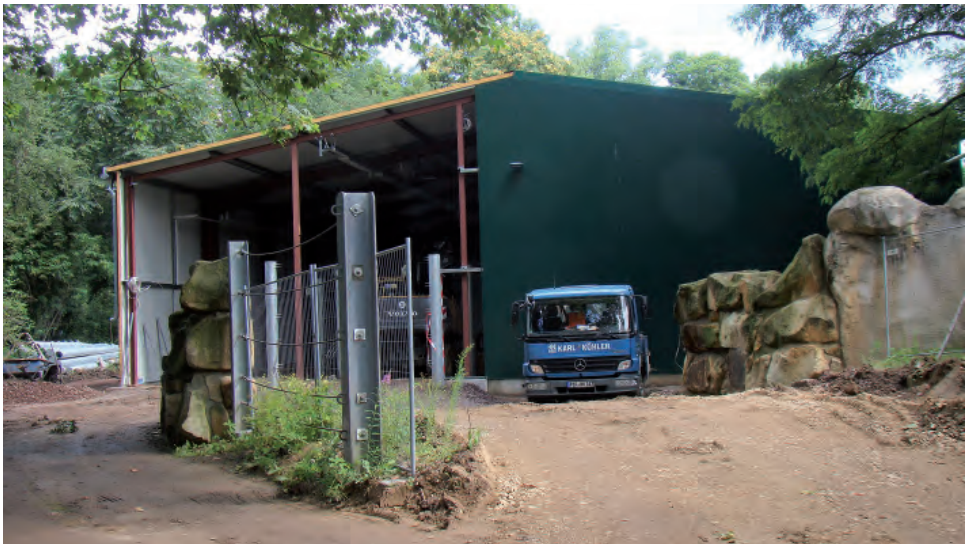
Abb. 3: Bau der Interimshalle an der Stelle des alten Raubtierhauses im Jahr 2014 als Vorbereitung für den eigentlichen Umbau des Afrikahauses. Foto: Archiv Zoo Dresden
