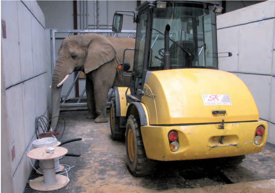
Abb. 4: Elefantenkuh Mogli beim Erkunden der Baustelle der Interimshalle – zur Zeit der Aufnahme wurden die Elefanten noch im direkten Kontakt gepflegt. Foto: Archiv Zoo Dresden
