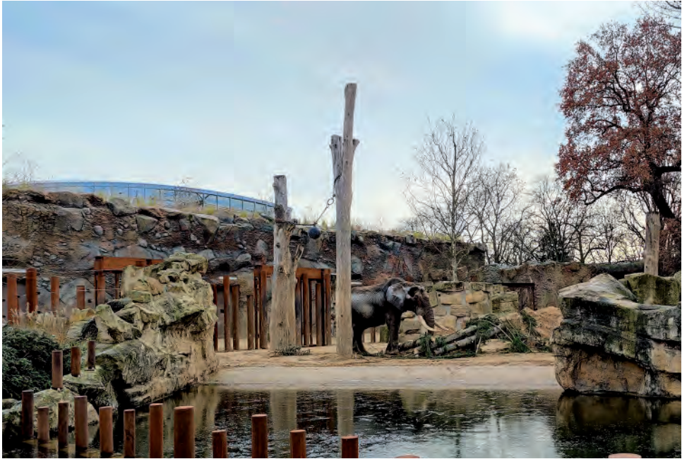
Abb. 8: Die Metallpfosten verhindern das Aussteigen eines Elefantenbullens aus dem 3 m tiefen Badebecken. Quelle: Zoo Dresden
